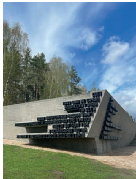
«Стена Скорби» — железобетонный блок с нишами, в которых находятся мемориальные плиты с названием свыше 260 лагерей смерти и мест массовой гибели людей
