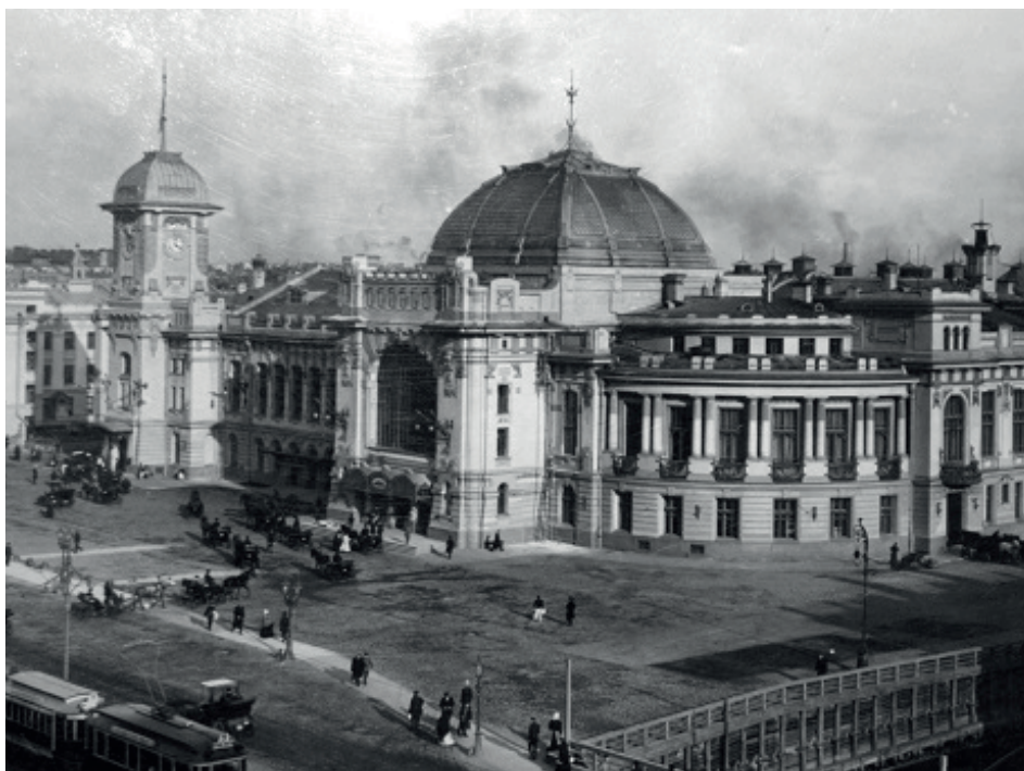
Здание Витебского вокзала в стиле модерн, возведенное в 1904 году.
